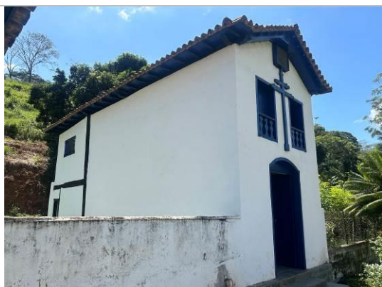
Figura 07: Fachadas frontal e lateral esquerda da Capela de Bom Jesus dos Perdões Autoria: Djair Junio de Souza Oliveira Data: 15/03/2024
