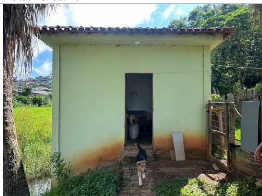
Figura 13: Vista da edificação que abriga o Moinho da Fazenda Passagem
