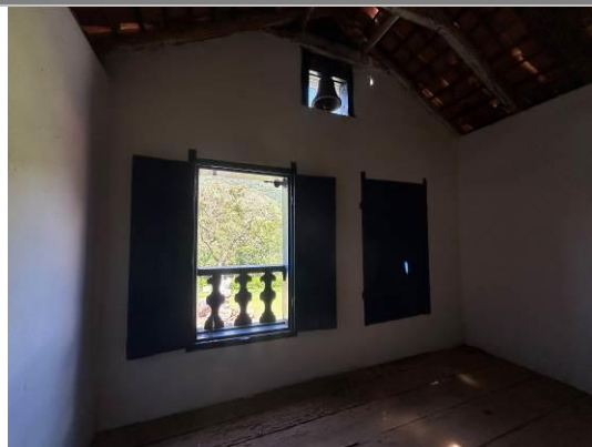
Figura 10: Vãos voltados para a fachada frontal da Capela de Bom Jesus dos Perdões
