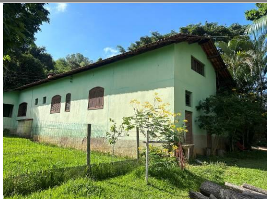
Figura 05: Fachadas frontal e lateral esquerda da Fazenda Passagem
