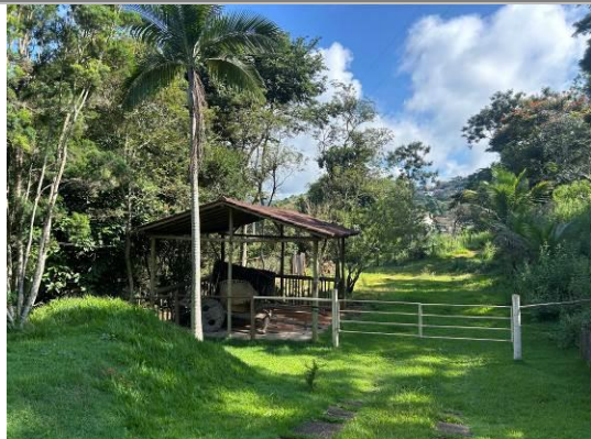
Figura 11: Cobertura para guarda dos carros de boi utilizados na Fazenda Passagem
