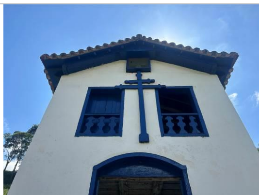
Figura 06: Detalhe da fachada frontal da Capela de Bom Jesus dos Perdões Autoria: Djair Junio de Souza Oliveira Data: 15/03/2024
