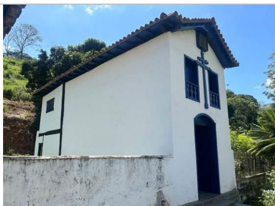
Figura 05: Fachadas frontal e lateral esquerda da Capela de Bom Jesus dos Perdões Autoria: Djair Junio de Souza Oliveira Data: 15/03/2024
