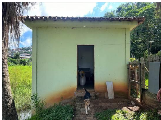
Figura 05: Vista da edificação que abriga o Moinho da Fazenda Passagem Autoria: Djair Junio de Souza Oliveira Data: 15/03/2024
