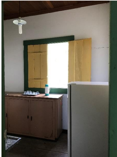
Foto 21: Vista interna do cômodo utilizado como copa. Pormenor da trinca horizontal, adjacente à janela. Autoria: Daniel Quintão. Data: 23/05/2019.
