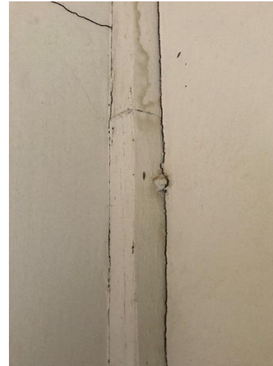
Foto 21: Vista interna do cômodo utilizado como copa. Pormenor da trinca horizontal, adjacente à janela. Autoria: Daniel Quintão. Data: 23/05/2019.
