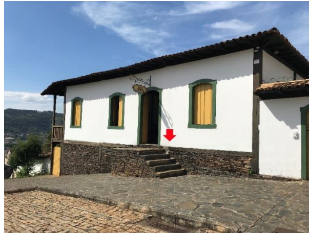
Foto 25: Vista externa do imóvel a partir do logradouro público. Indicação da região onde ocorre a ancoragem da madre em questão. Autoria: Daniel Quintão. Data: 23/05/2019.
