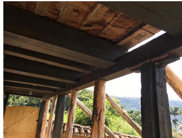
Foto 05: Vista parcial do barroteamento da varanda lateral na região de uma das junções da madre. Autoria: Daniel Quintão. Data: 23/05/2019
