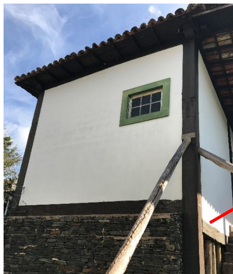
Foto 15: Vista parcial da fachada posterior. Pormenor da junção no esteio. Autoria: Daniel Quintão. Data: 23/05/2019.
