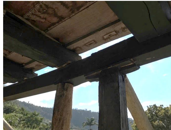
Foto 03: Pormenor da madre intermediária na região da junção. Detalhe para o deslocamento da peça em relação aos barrotes. Autoria: Daniel Quintão. Data: 23/05/2019
