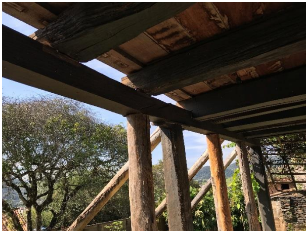
Foto 04: Pormenor da madre intermediária na região da junção. Detalhe para o deslocamento da peça em relação aos barrotes. Autoria: Daniel Quintão. Data: 23/05/2019
