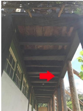
Foto 02: Vista geral do barroteamento da varanda lateral. Autoria: Daniel Quintão. Data: 23/05/2019
