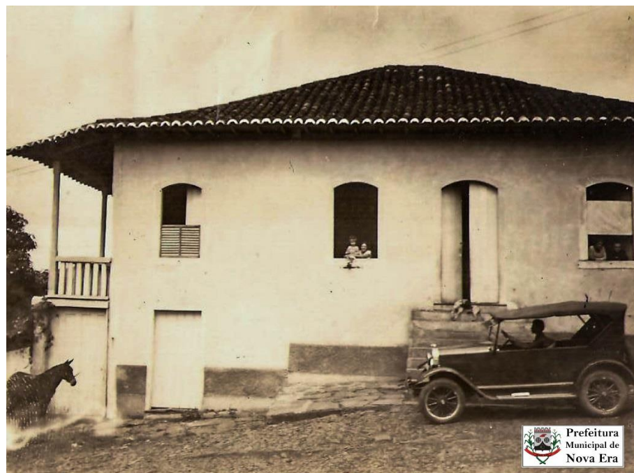
Foto antiga do imóvel sede do Museu Municipal.
