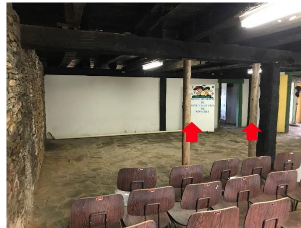
Foto 27: Vista parcial do porão e pontaletes instalados para escoramento da madre em resposta ao abatimento identificado. Autoria: Daniel Quintão. Data: 23/05/2019.
