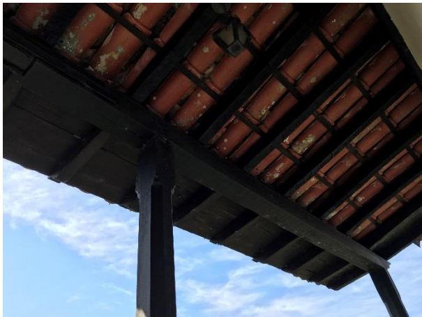
Foto 10: Vista parcial da cobertura da varanda. O trecho de frechal, em tora de madeira serrada, apresenta aspecto de fatura recente e junção reforçada com chapa metálica. Autoria: Daniel Quintão. Data: 23/05/2019
