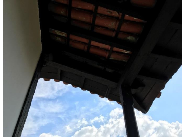
Foto 07: Pormenor do frechal transversal, conforme configuração original. Autoria: Daniel Quintão. Data: 23/05/2019
