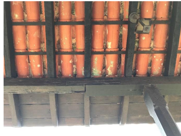
Foto 10: Vista parcial da cobertura da varanda. O trecho de frechal, em tora de madeira serrada, apresenta aspecto de fatura recente e junção reforçada com chapa metálica. Autoria: Daniel Quintão. Data: 23/05/2019
