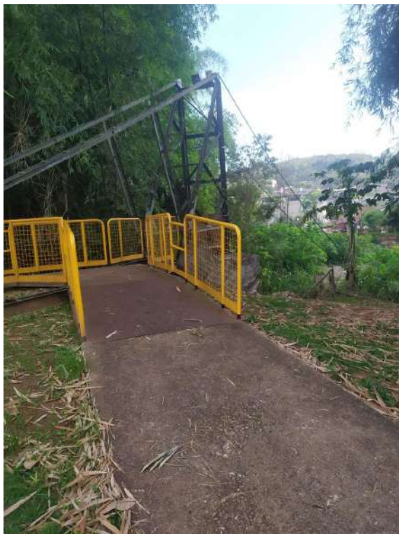
Figura 8: Ponte do Rio Piracicaba.
