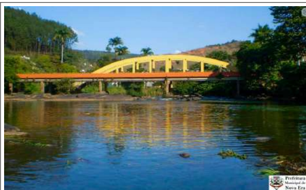
Figura 3 – Foto da situação geral da ponte Benedito Valadares.
