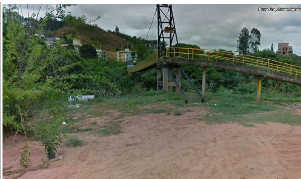
Figura 12 – Passarela antiga, evidenciando a supressão vegetal já realizada.
